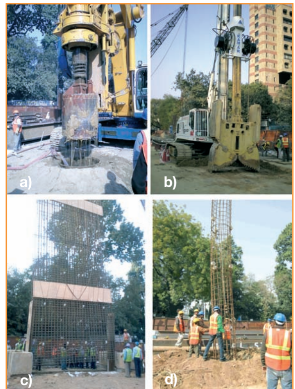
[Fig. 7].- a) Pilotadora perforando; b) Máquina de excavación de pantallas; c) Colocación de la armadura de una pantalla; d) Colocación de una armadura de un pilote.
