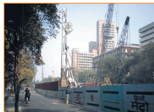
Vista de las obras en una de las avenidas.
